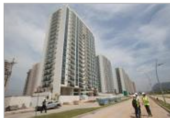
En esta imagen del 16 de marzo de 2015, trabajadores ante la villa olímpica de 2016 en Río de Janeiro, Brasil. Los promotores del proyecto afirman que las residencias para deportistas estarán a la altura de hoteles de cinco estrellas. (AP Foto/Silvia Izquierdo)
